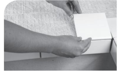
S'assurer que les carreaux du dessus du comptoir les chevauchent et utiliser les cales d'espacement pour un joint de coulis uniforme.
