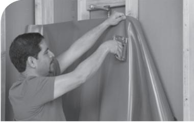
Clouer ou agraffer un feutre de toiture ou une pellicule de polyéthylène aux montants du mur.
