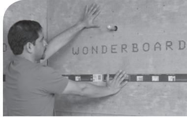
Installer un panneau d'appui de ciment 13 mm (1/2") pour installation murale. Découper les trous pour la plomberie.
