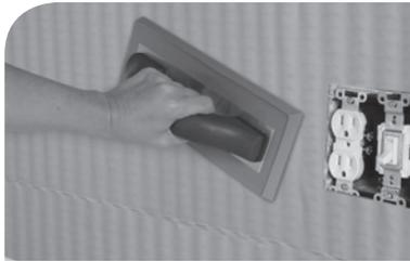
Appliquer la membrane SimpleMat en lissant pour éliminer les bulles d'air ou les faux plis.
