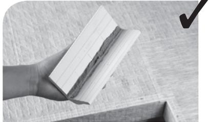
Si le carreau en forme de V ne s'adapte pas complètement à la surface, utiliser un coulis simple SimpleGrout, un coulis pré-mélangé ou un produit de calfatage pour le carrelage et les accessoires de céramique SimpleFix pour remplir les vides entre les carreaux et la surface.
