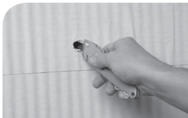
Appliquer le SimpleMat et découper autour de l'ouverture sur le panneau d'appui. Lisser pour éliminer les bulles d'air et lessur faux plis.
